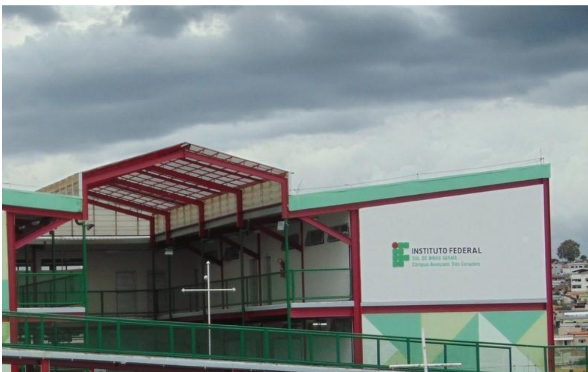
Figura 8 – Fachada do Campus Avançado Três Corações
